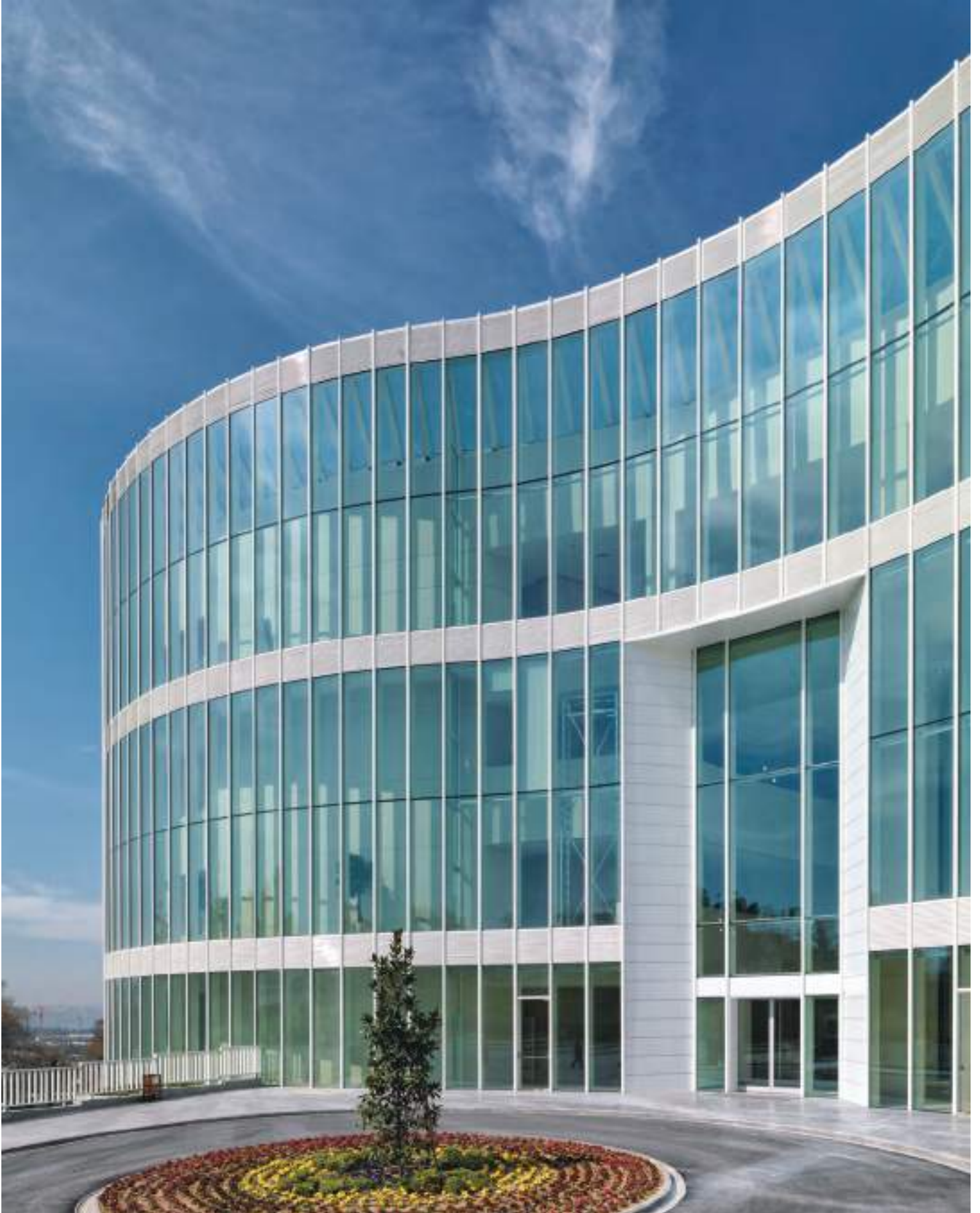
Küçükçekmece Belediyesi / İstanbul — Kalesinterflex 3mm Fit Mat Beyaz / Gizli Klipsli Sistem Küçükçekmece Municipality / İstanbul — Kalesinterflex 3mm Fit Matte White / Hidden Clips Fitted Facade System Mimar: Mutlu Çilingirođlu Architects — Architect: Mutlu Çilingirođlu Architects
