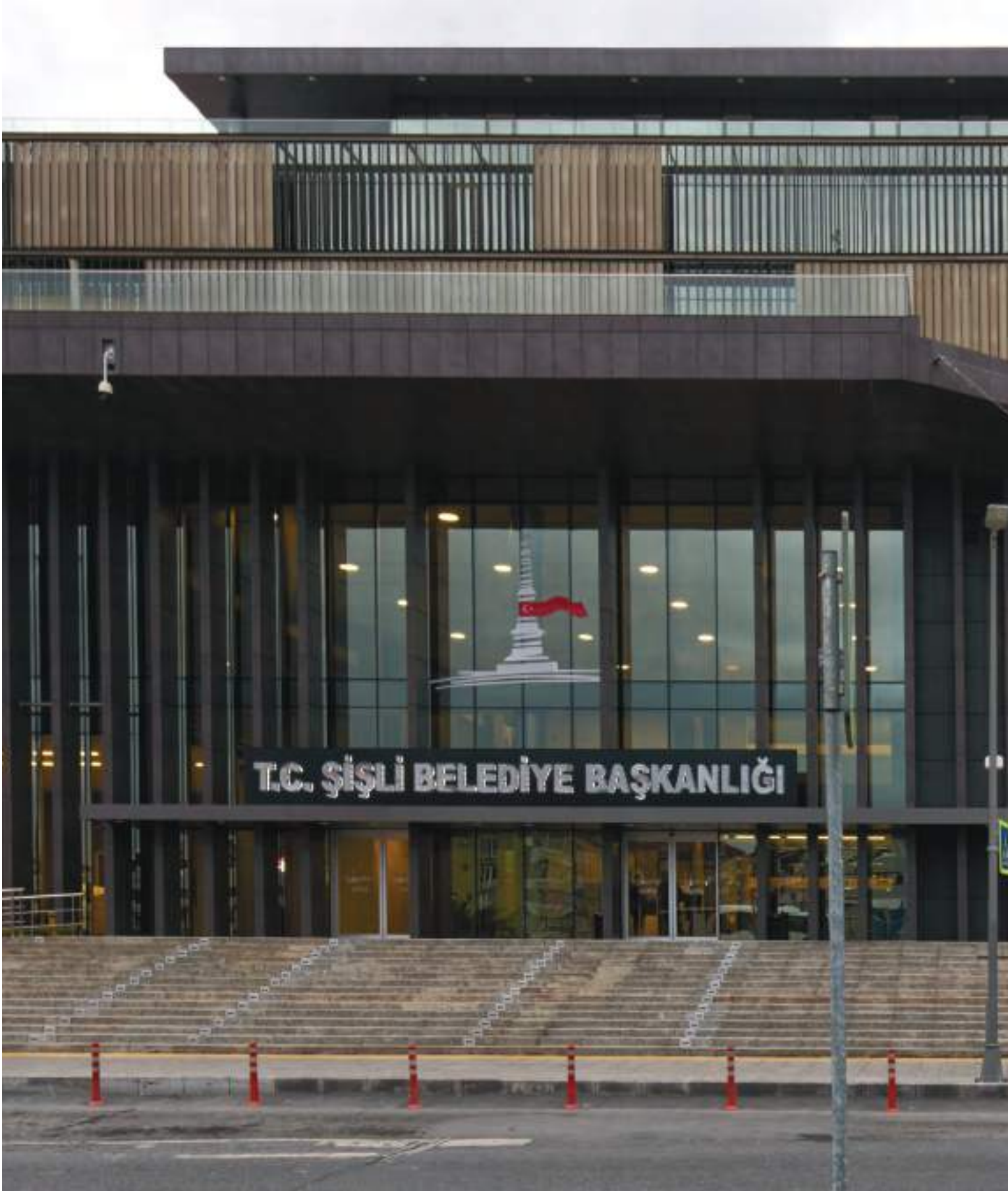
Şişli Belediyesi Ek Hizmet Binası / İstanbul — Kalesinterflex 3mm Fit Luxury Cement Antrasit / Gizli Klipsli Sistem
