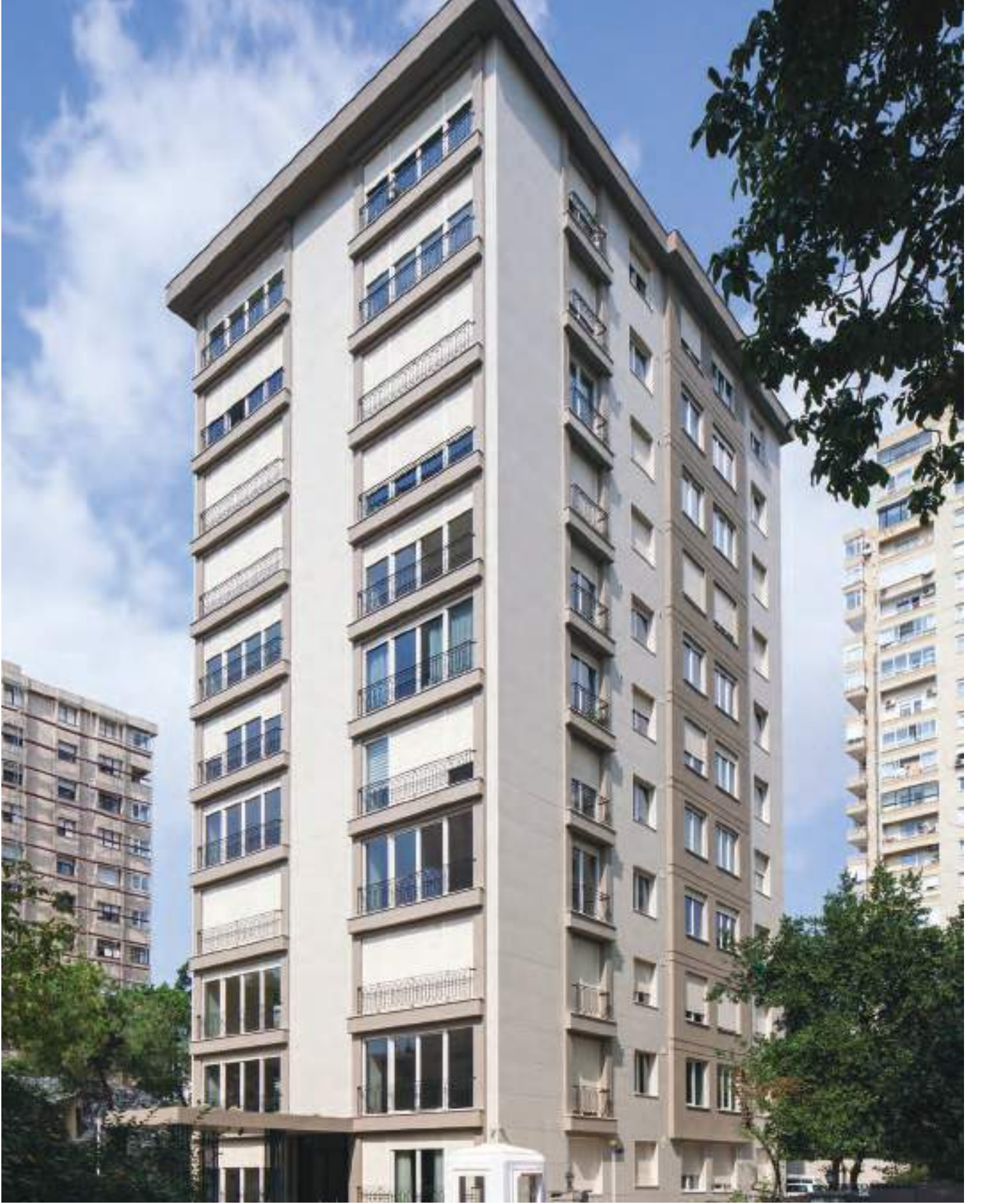
Türegün Apartmanı, Erenköy / İstanbul — Kalesinterflex 3mm Fit C-Stone Açık Kahve / Gizli Klipsli Sistem Türegün Apartment, Erenköy / İstanbul — Kalesinterflex 3mm Fit C-Stone Light Brown / Hidden Clips Fitted Facade System Birgen İnşaat
