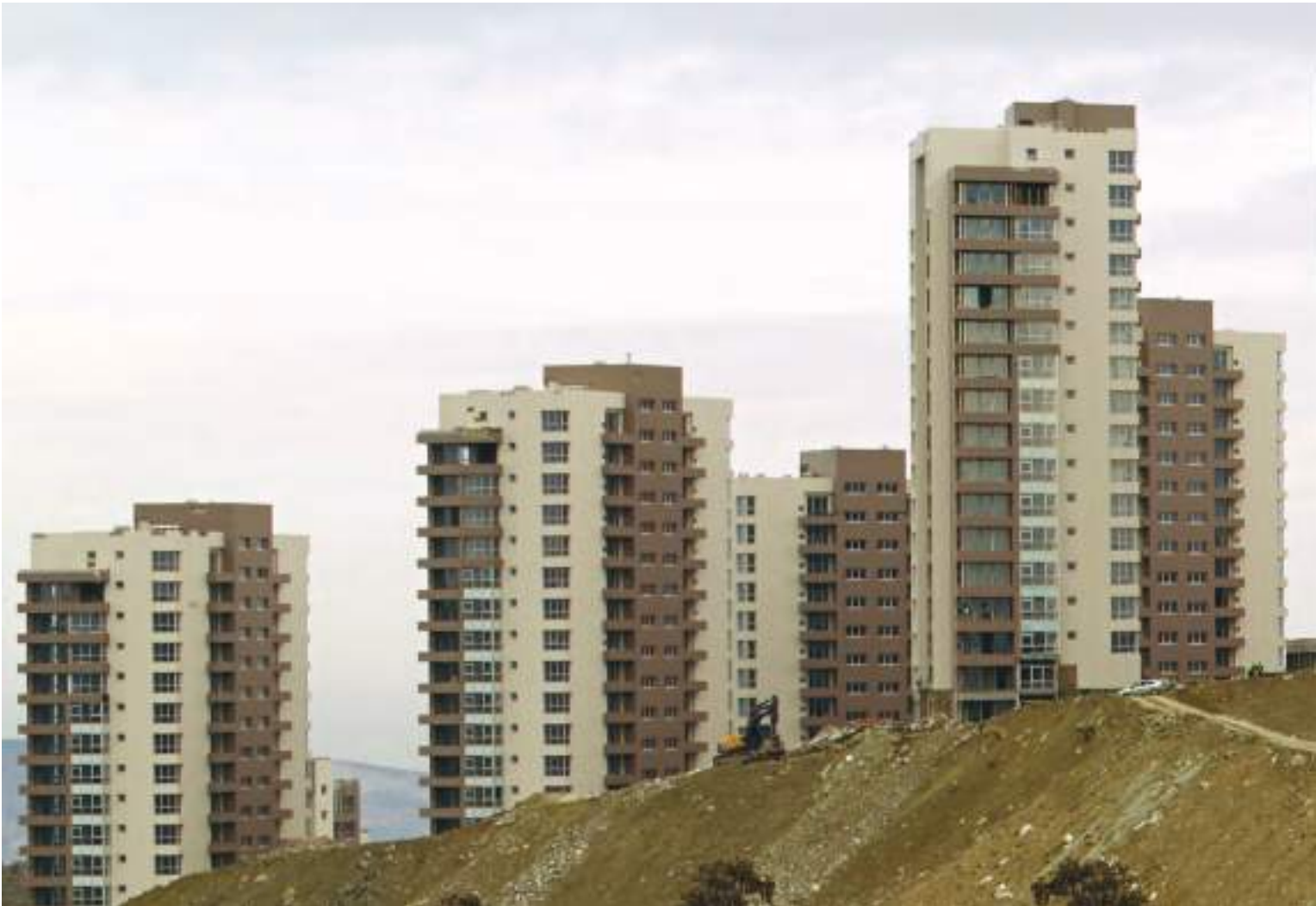
Toki İncek Konutları / Ankara — Kalesinterflex 3mm Fit Mat Beyaz, 3mm Fit Mat Bej Gri / Gizli Klipsli Sistem
