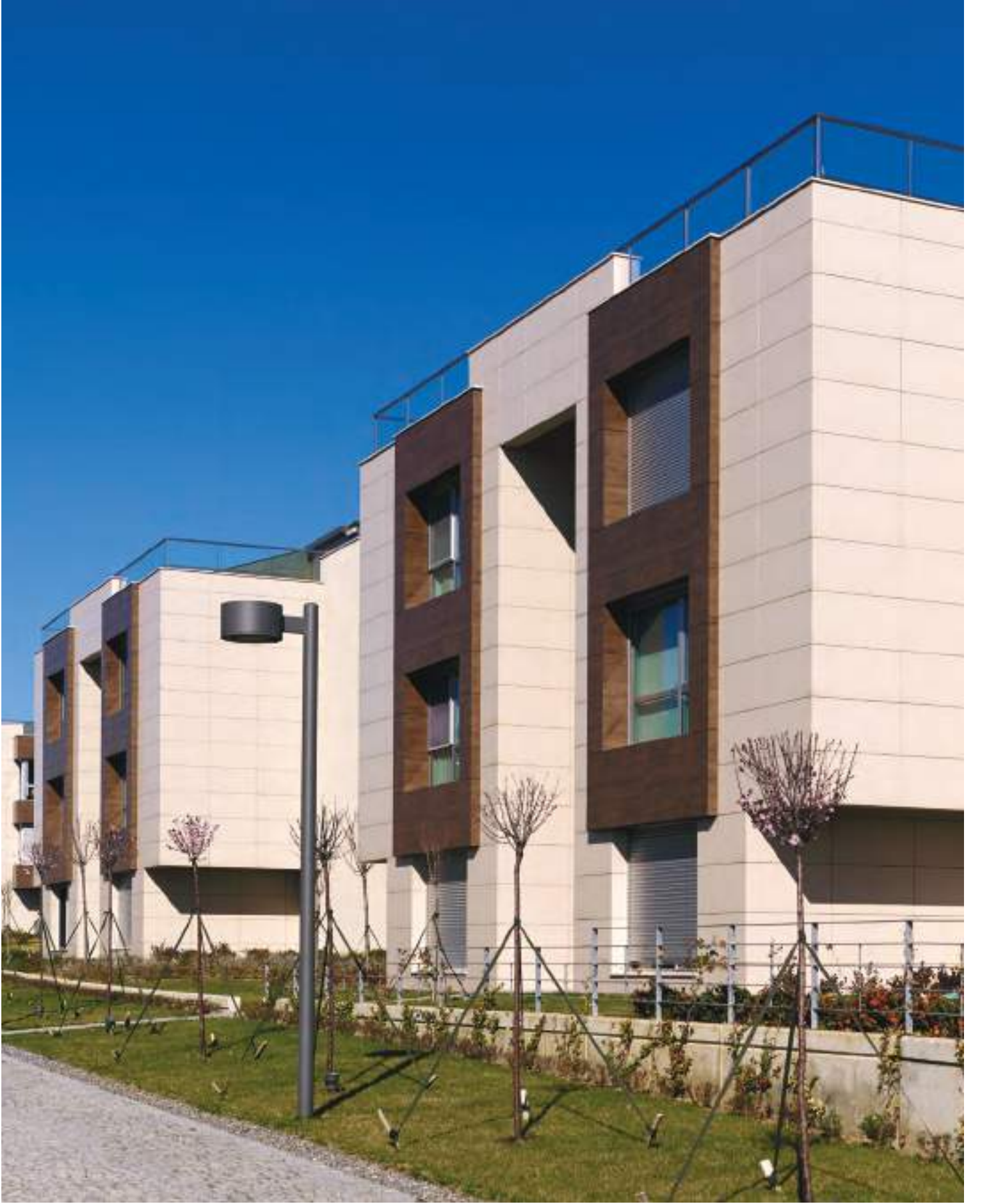
Mesa Mesken Çengelköy Konutları / İstanbul — 60x120cm Düz Bej Mat / Gizli Sistem Mesa Mesken Çengelköy Residence/ İstanbul — 24"x48" Solid Beige Matte / Invisible System Mimar: Mesa Tasarım Grubu — Architect: Mesa Design Group
